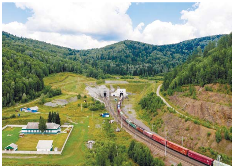
Нанчульский тоннель южного хода
