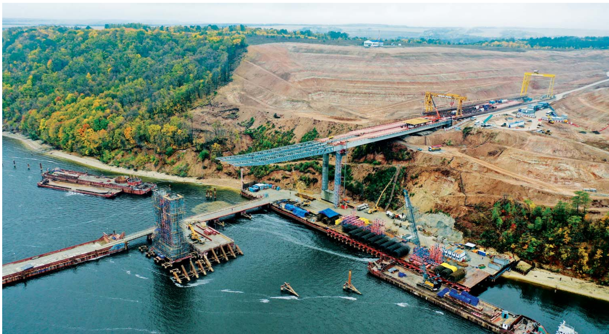
Мост через Волгу в Татарстане длиной 3360 м станет самым длинным искусственным сооружением на всем протяжении М-12
