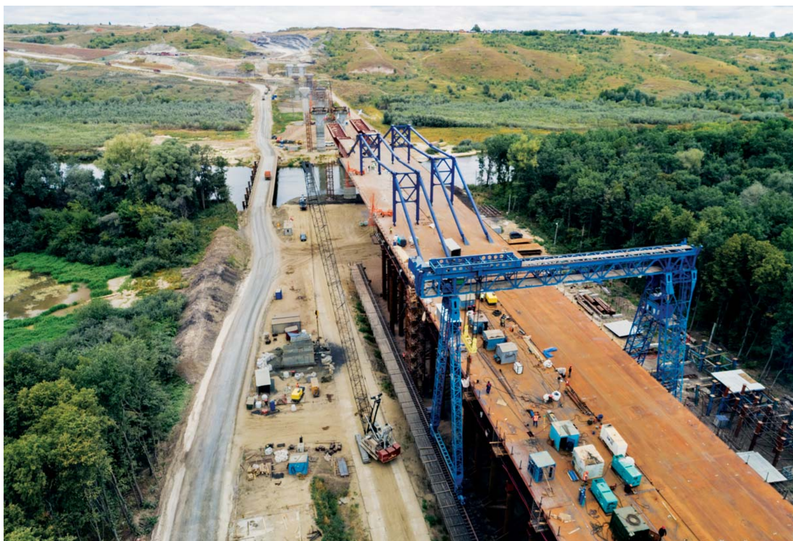
Мост через реку Сура соединит Нижегородскую область и Чувашскую Республику
