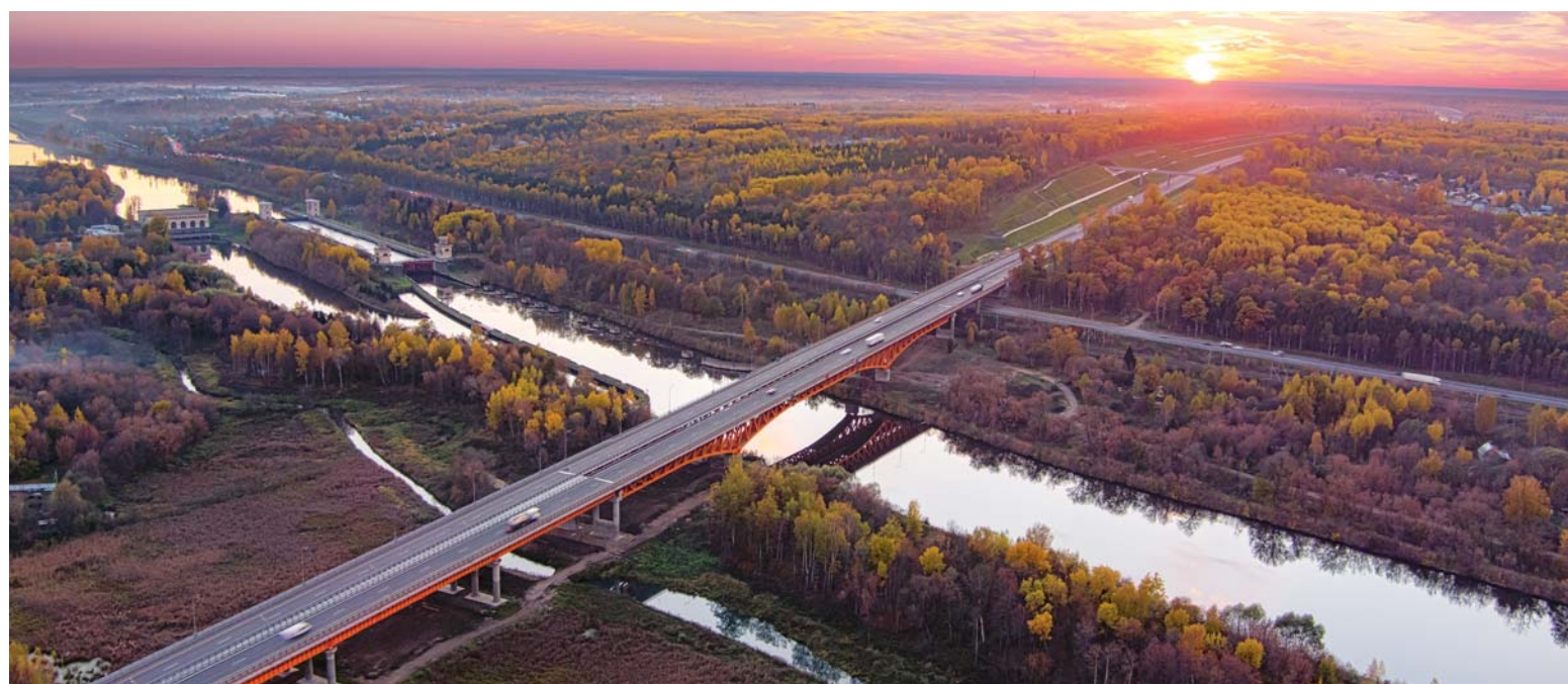
Центральная кольцевая автодорога является одним из ключевых элементов транспортной системы Москвы и основной опорной сети скоростных автодорог России
