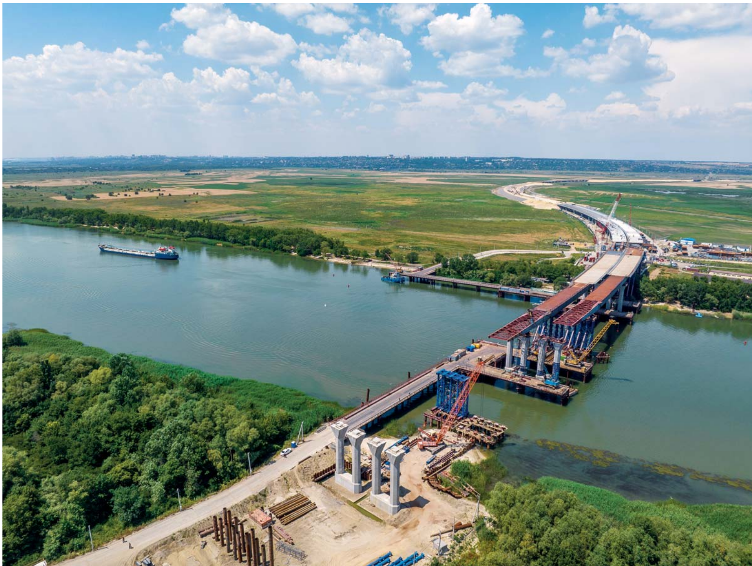
Продолжаются активные строительные работы на самом крупном мосту через реку Дон длиной более 1900 м
