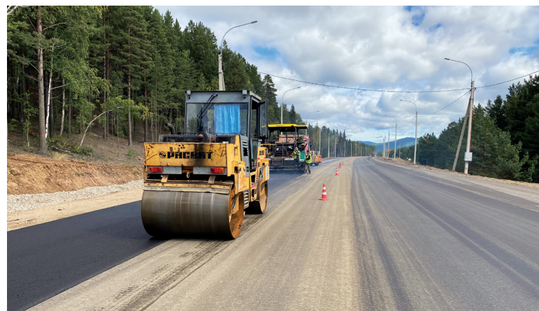
Реконструкция автодороги Улан-Удэ – Турунтаево, Республика Бурятия
