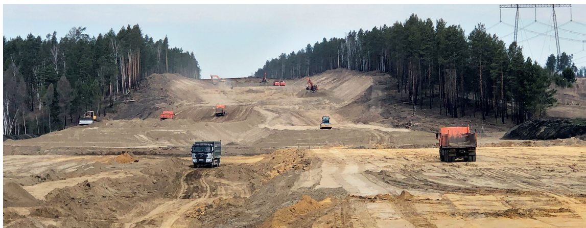
Обход Усолья-Сибирского, Иркутская область
