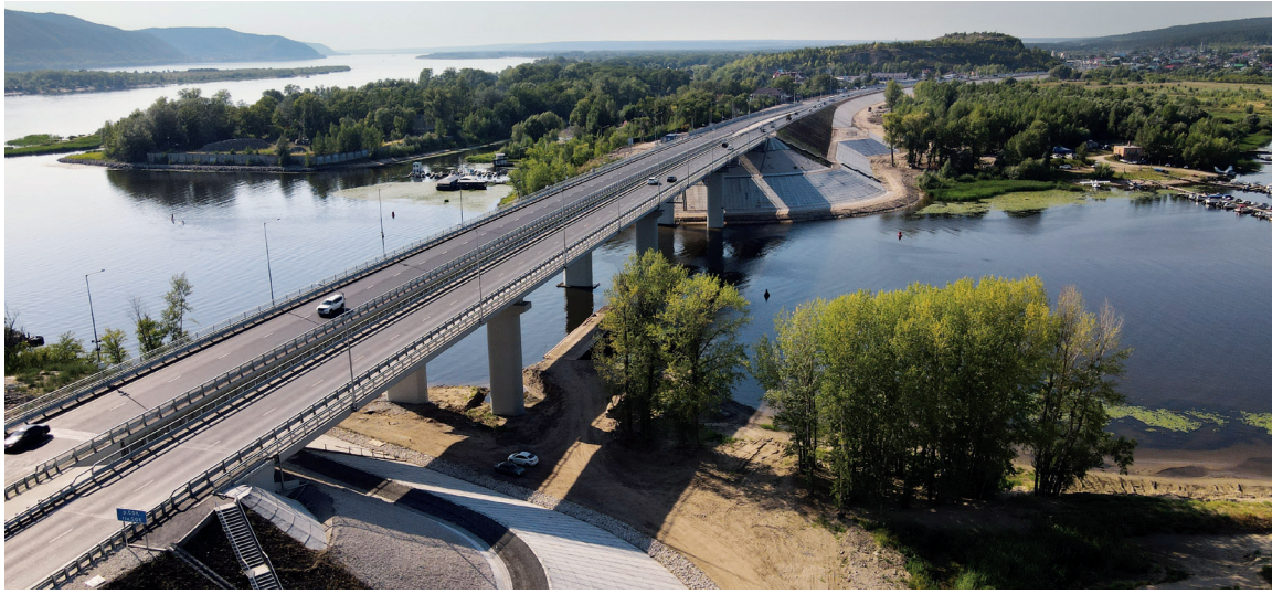
Мост через реку Сок, Самарская область
