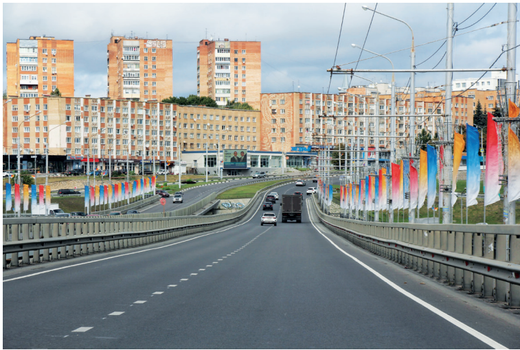
Газаринский мост, г. Калуга
