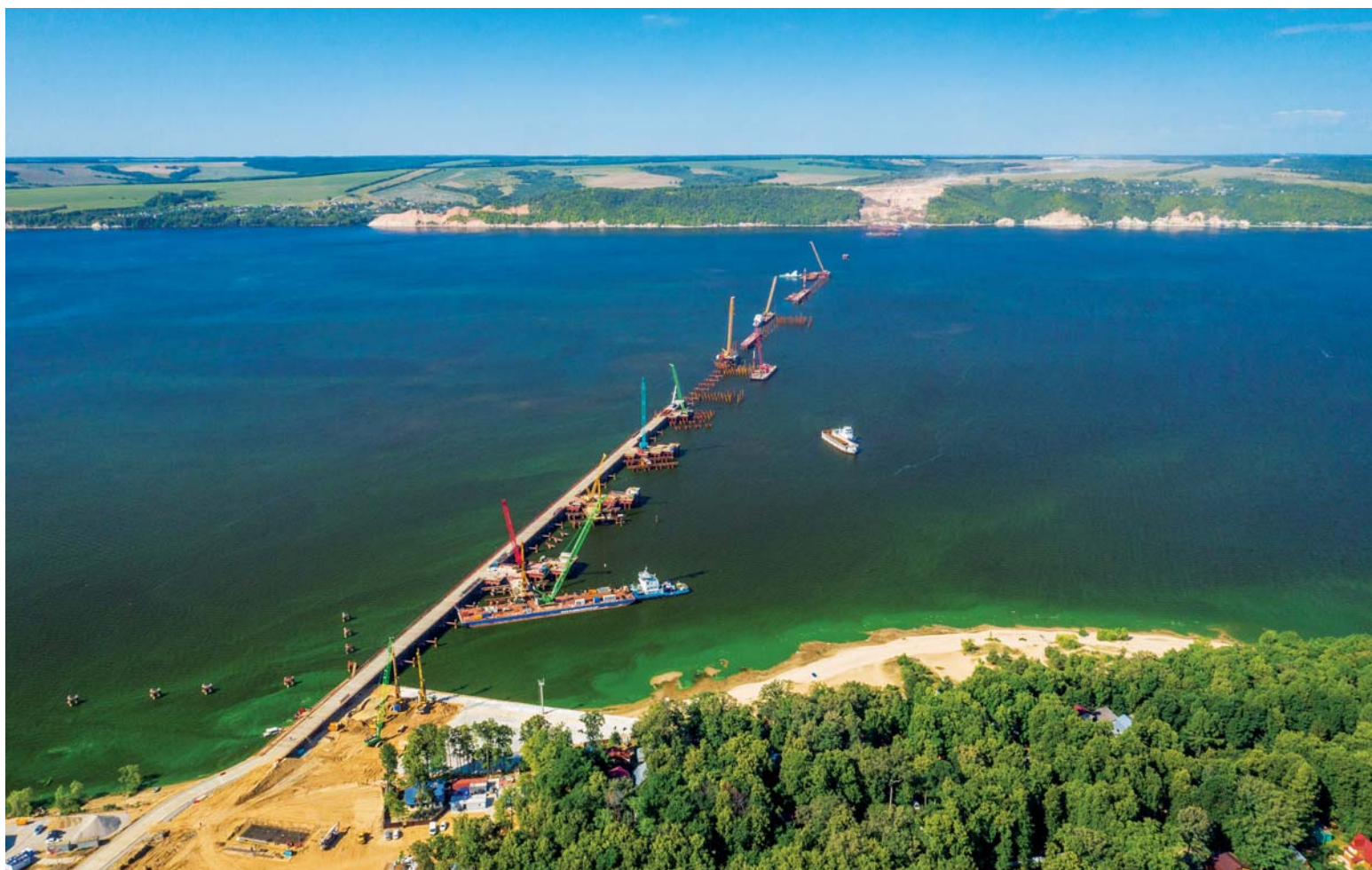
Для возведения на М-12 мостового перехода через Волгу, длиной 3342,64 м, построен технологический мост. По нему будут доставлять материалы и технику
