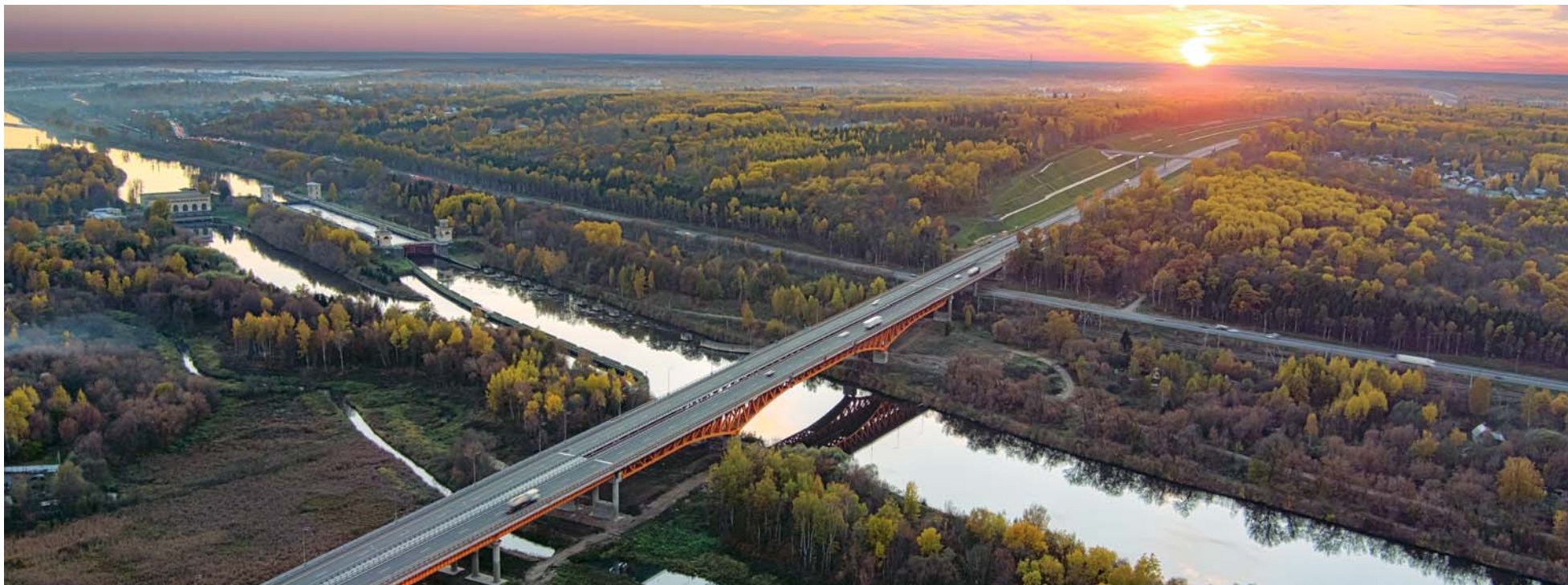
Самый живописный мостовой переход на ЦКАД, через канал имени Москвы. Он пересекает три транспортные артерии, в том числе Дмитровское шоссе и Савеловское направление Московской железной дороги. Проходит над рекой Икша и региональной дорогой. Его длина 1410 метров, общий вес металлоконструкций – 9500 тонн
