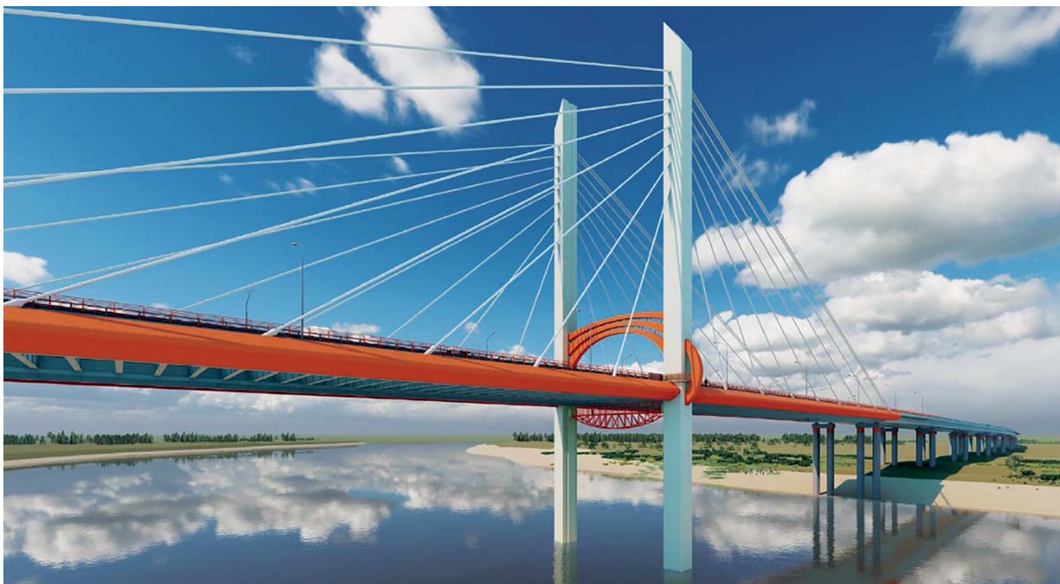
Единственный вантовый мост протяженностью 1377,6 м на М-12 соединит берега Владимирской и Новгородской областей
