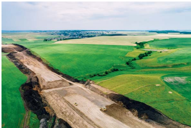
Подготовка территории к строительству М-12 идет по всей ее протяженности, в пяти регионах, в том числе и в Республике Чувашия
