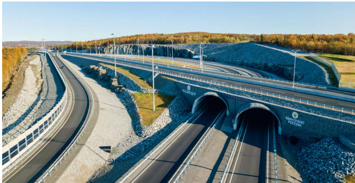
Путепровод тоннельного типа транспортной развязки на участке км 1378 – км 1381, Р-21 «Кола»
