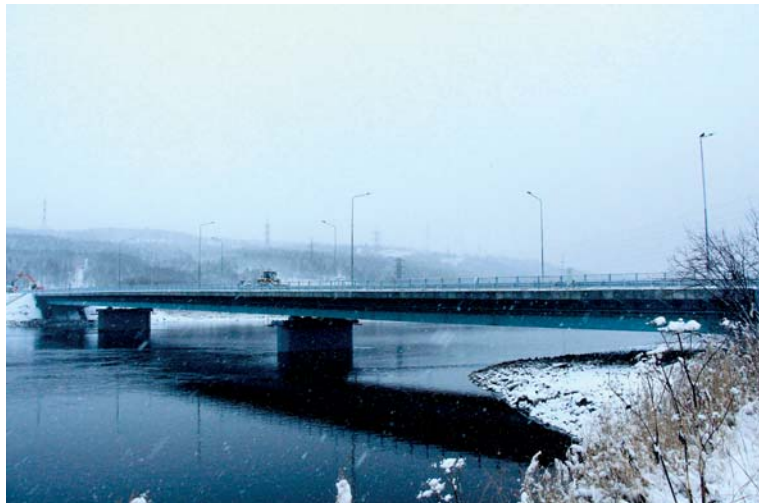
Мост через реку Тулому
