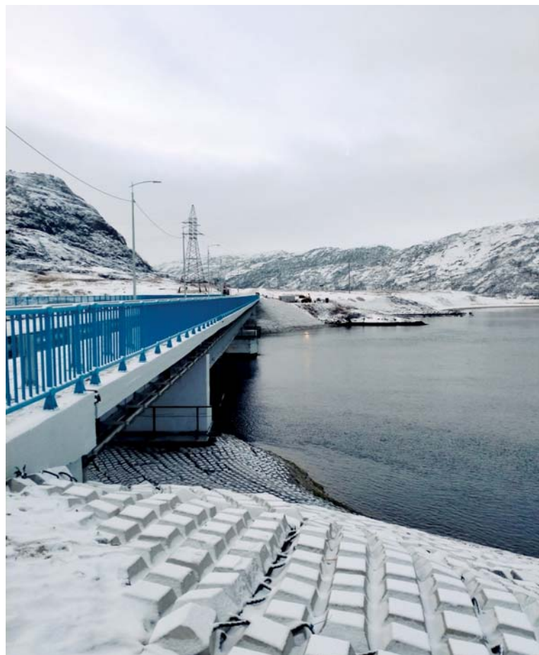
Мост через реку Териберка
