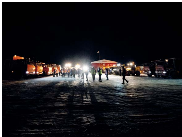
Реконструкция аэродрома Петропавловск–Камчатский (Елизово). 13.12.2021 г. Утро на стройплощадке
