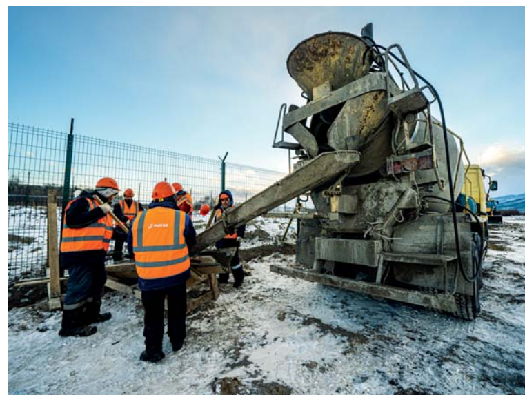
Реконструкция аэродрома Петропавловск–Камчатский (Елизово). 13.12.2021 г. Возведение охранного периметра
