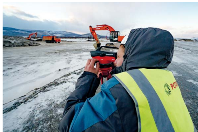
Реконструкция аэродрома Петропавловск–Камчатский (Елизово). 13.12.2021 г. Геодезист на площадке
