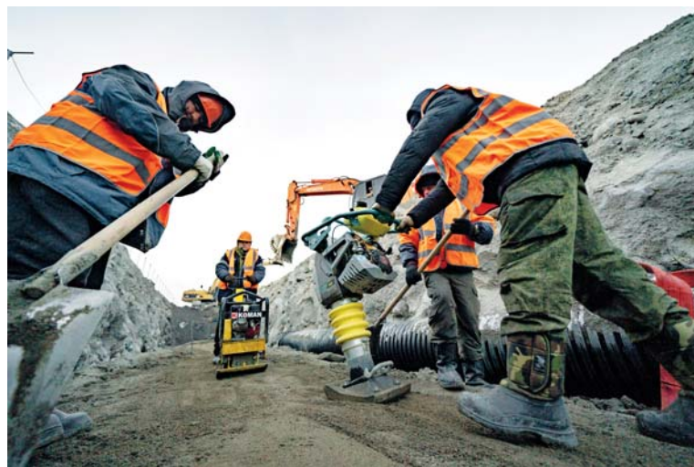
Реконструкция аэродрома Петропавловск–Камчатский (Елизово). 13.12.2021 г. Укладка коммуникаций
