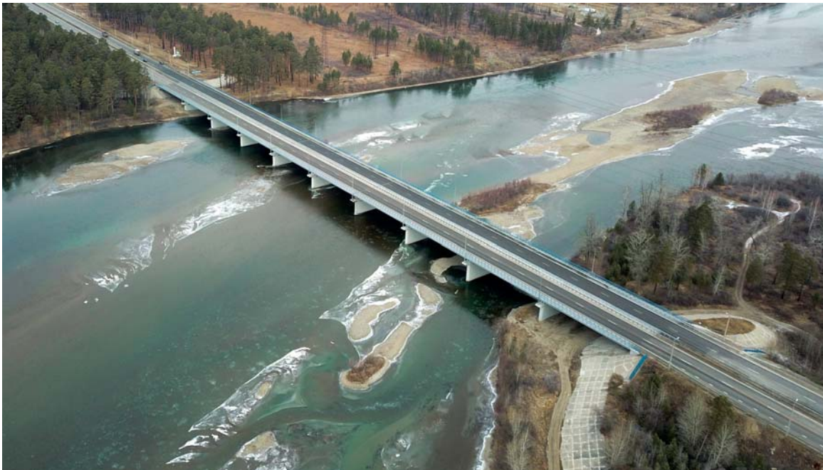
Ремонт моста через р. Китой, км 1843 а/д Р-255 «Сибирь»
