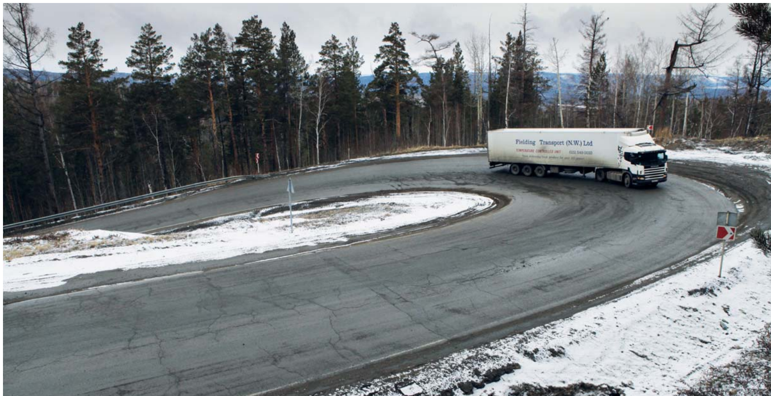
«Тещин язык» – участок федеральной автодороги Р-258 «Байкал», км 47– км 55 до реконструкции
