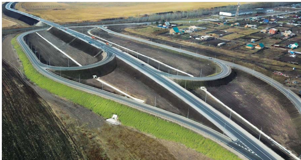
Капитальный ремонт а/д Р–255 «Сибирь», км 1768 – км 1777 (в т. ч. транспортная развязка на км 1777)
