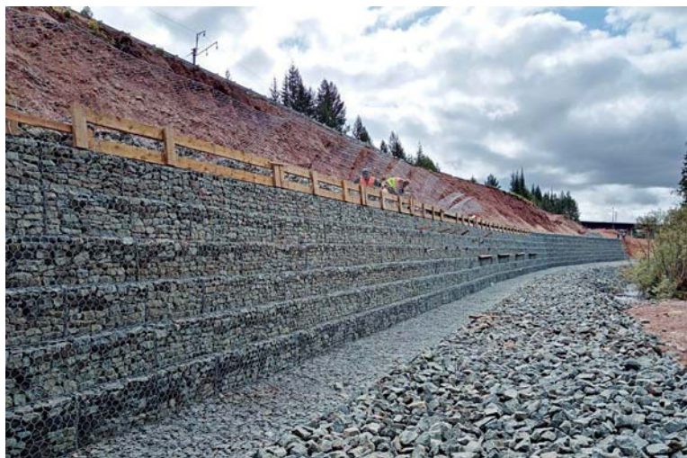
Устройство подпорной стенки капитального ремонта А–331 «Вилкой», км 344 – км 350
