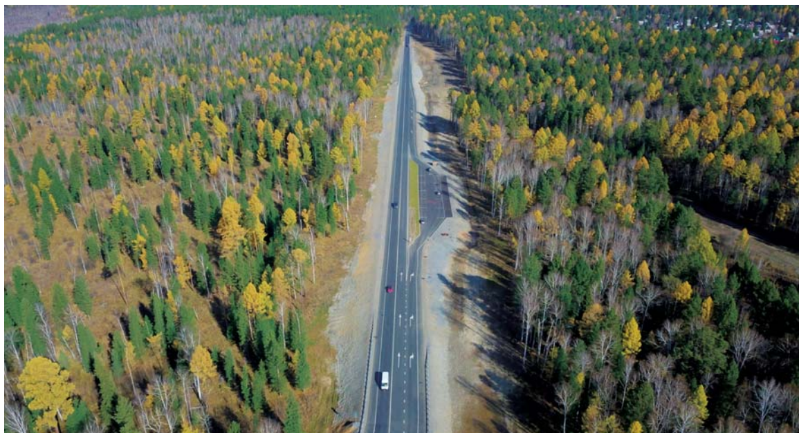
Участок федеральной автодороги Р-258 «Байкал», км 47– км 55 после реконструкции
