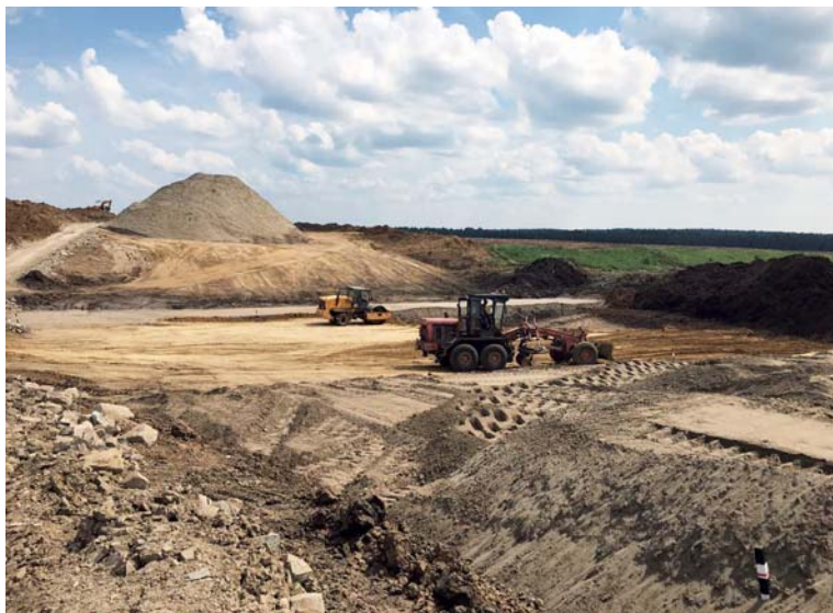
Строится обход села Тулушка
