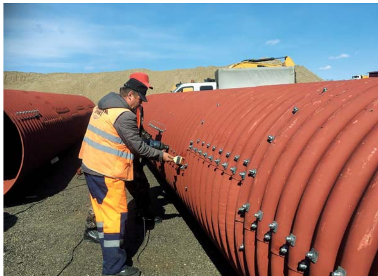
Гофротрубу готовят к укладке
