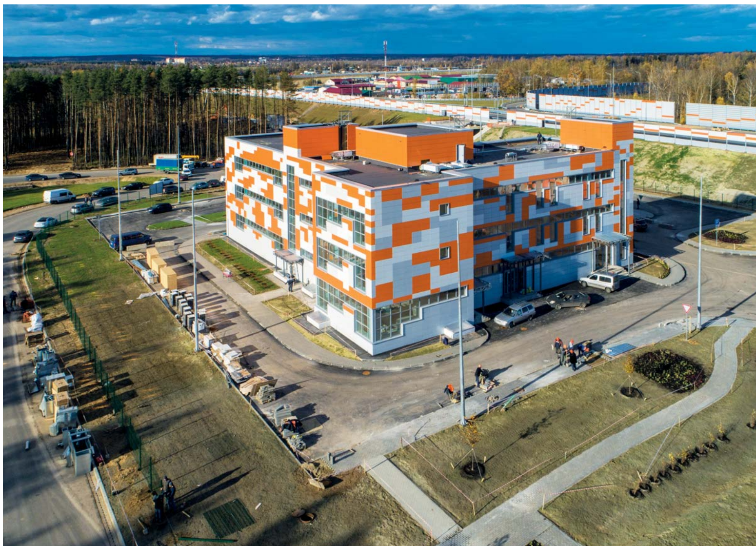
Фасад Центрального пункта управления ЦКАД и другие элементы трассы выдержаны в единой цветовой гамме
