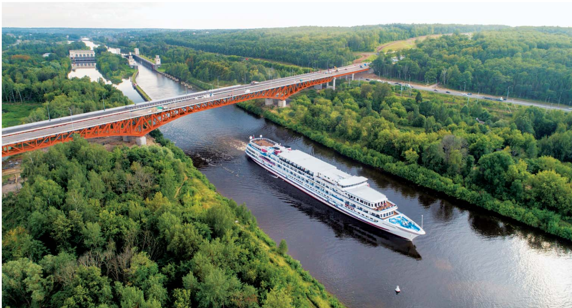
Жемчужиной ЦКАД стал мостовой переход через канал им. Москвы
