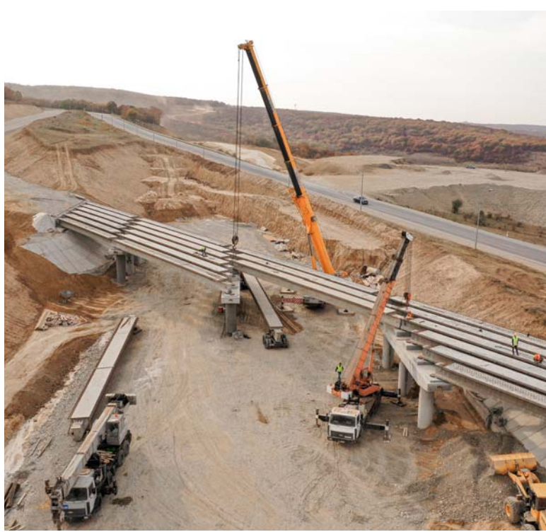
На снимке: строительство обхода Гудермеса
