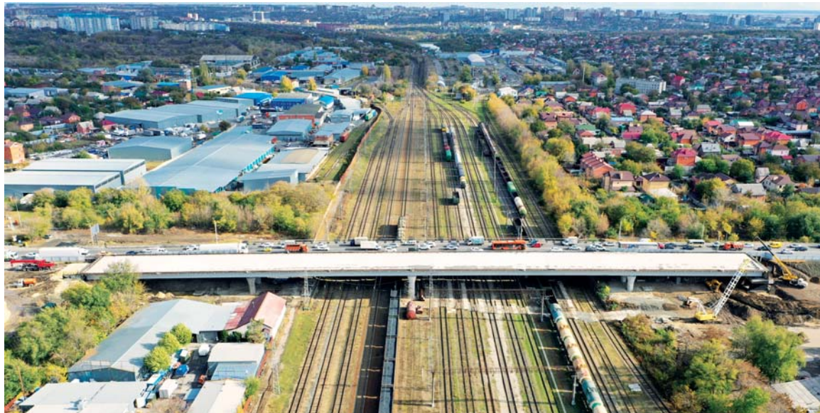
Путепровод на улице Малиновского в Ростове-на-Дону
