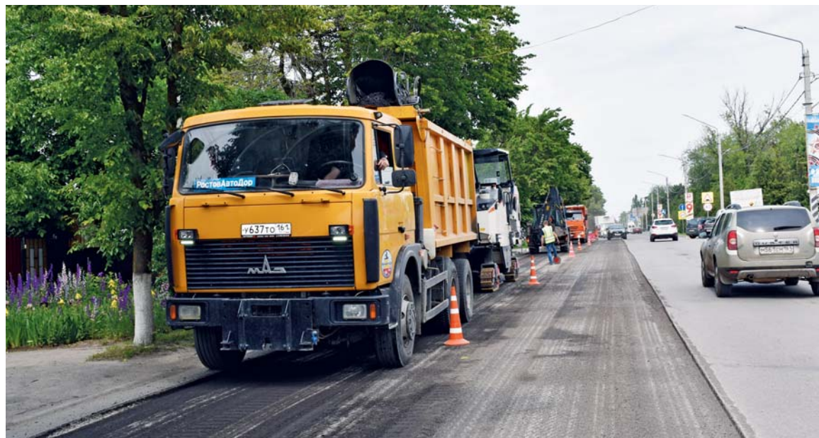
Ремонт участка ул. Московской, Азов
