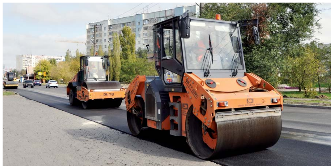
Ремонт улицы Сухэ-Батора в Элисте
