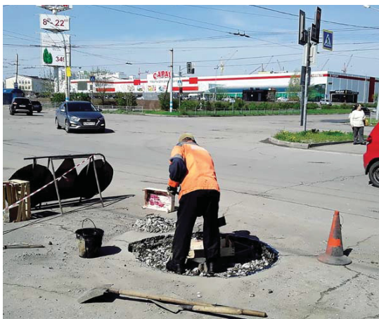
Проект Авиастроителей – ремонт дождеприемного колодца
