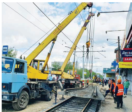
В городе активно идет ремонт трамвайных путей
